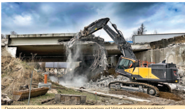
Demontáž dálničního mostu je s novým rypadlem od Volva zase o něco rychlejší
