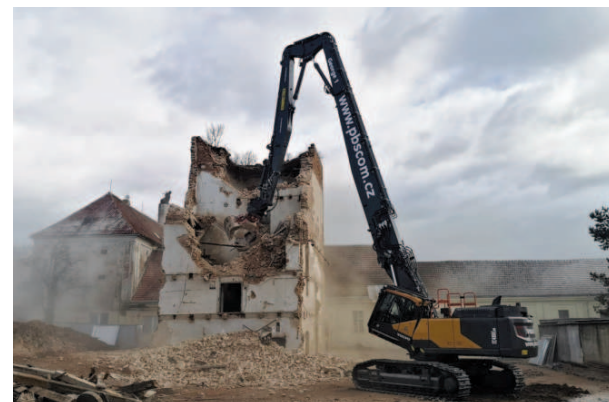
Premiéru si rypadlo odbylo při demolici 4podlažní budovy ve Velkých Hamrech u Harrachova
